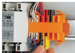
Inserindo um conector de caixa de junção MICRO no suporte de montagem.
