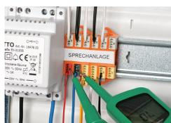
Testes via porta de teste oposta à entrada do condutor.
